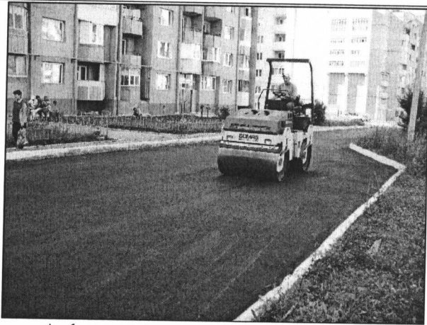
Асфальтирование дворовых проездов
