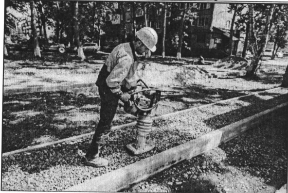
Устройство (ремонт) тротуаров
