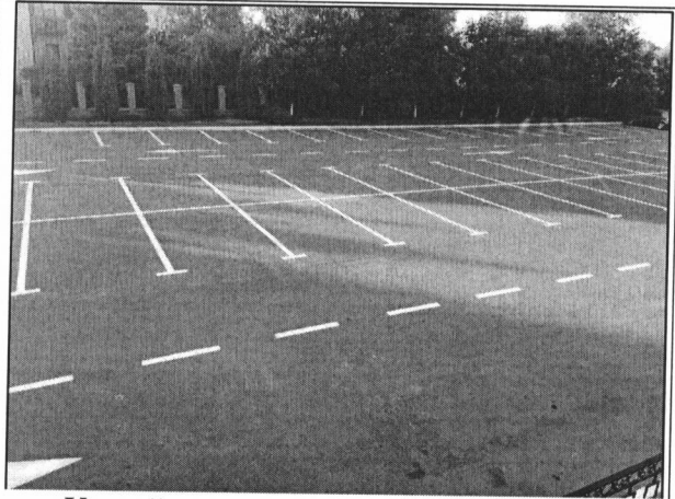
Устройство парковочных пространств
